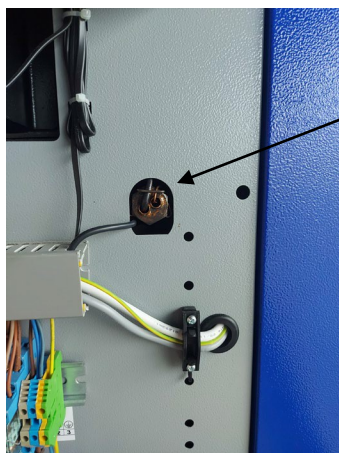
Doigt de gant avec bulbe de la sécurité thermique STB et la sonde de température de chaudière
